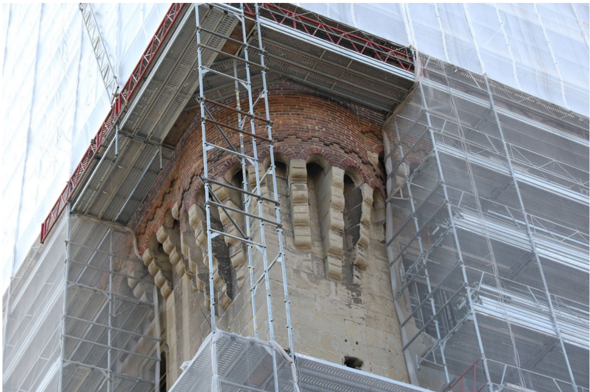
Fig. 4 et 5. Les 4 tourelles ont été dégagées des filets de protection avant l'arrivée des Martinets alpins. 23 mars 2016. L. Maumary.
