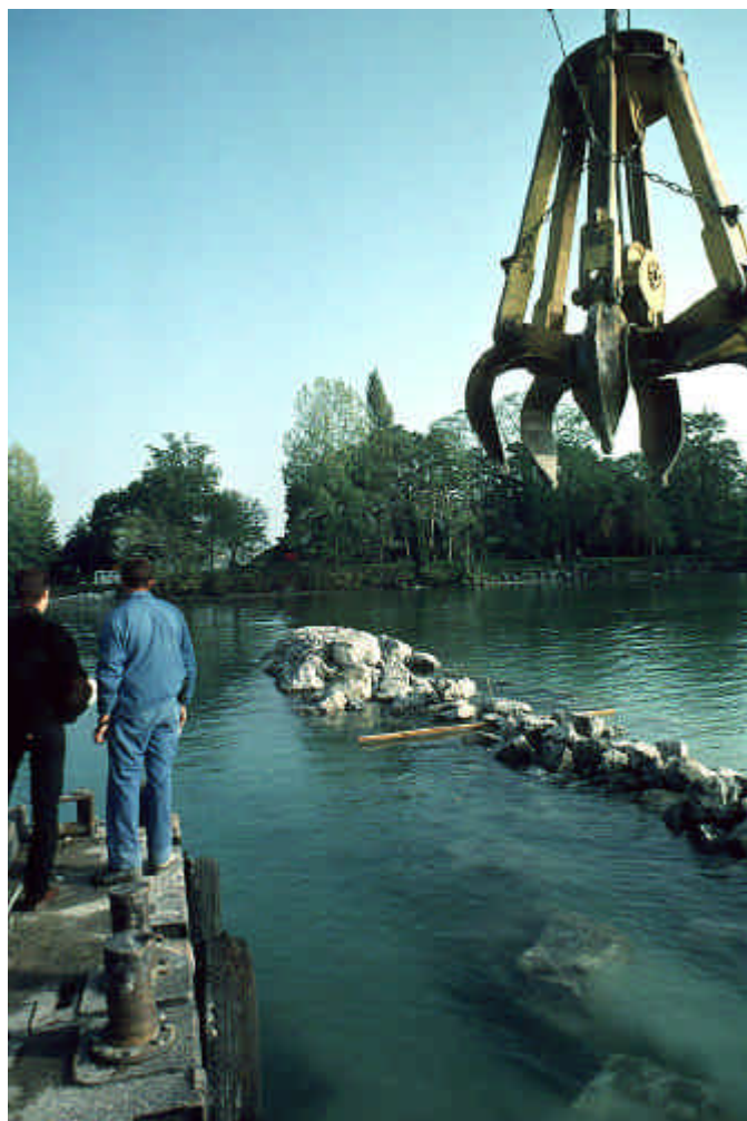
Fig. 8. La construction commence par la pose du cœur de l'enrochement (petits blocs), suivi de l'ajustage précis des gros blocs qui donneront sa forme à la digue. Un chenal est creusé pour permettre au ponton d'accéder à cette partie peu profonde du chantier. Préverenges, octobre 2001. L. Vallotton
