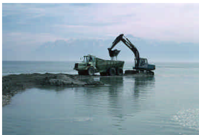
Fig. 13. La pelle retro extrait les matériaux de l'embouchure de la Venoge et crée la piste d'accès pour le camion (dumper) servant au transport. Préverenges, mars 2002. L. Maumary
