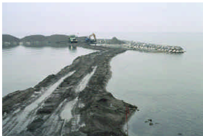
Fig. 15. Une piste faite avec les matériaux de la Venoge permet au camion d'accéder à l'île, où une pelle mécanique égalise les tas selon le plan précis établi par le Groupe «Île aux oiseaux». Préverenges, mars 2002. L. Vallotton
