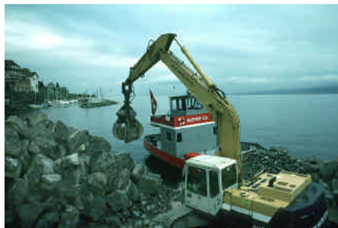
Fig. 6. La construction de l'île commence par le chargement des matériaux sur une barge. Différentes tailles de blocs sont nécessaires à l'élaboration de la structure de l'enrochement. Carrière de Meillerie (France), octobre 2001. L. Vallotton
