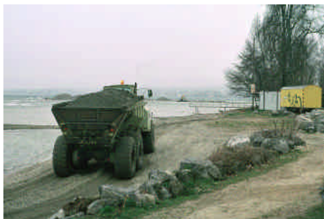
Fig. 14. Les 2'000 m 3 de matériaux pris dans la Venoge sont acheminés vers l'île avec un «dumper». Préverenges, mars 2002. L. Vallotton
