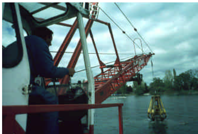
Fig. 9. Pose de blocs reposeirs. Les blocs erratiques étaient jadis nombreux sur le rivage. Ils ont aujourd'hui disparu, utilisés pour la construction. Préverenges, novembre 2001. L. Vallotton
